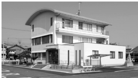
▲改修された佐織支所
